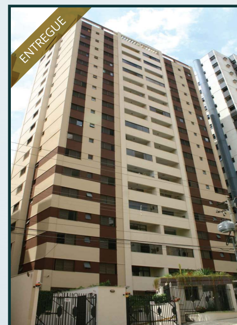
RES. SOLAR RAVENNA - GOIÂNIA
